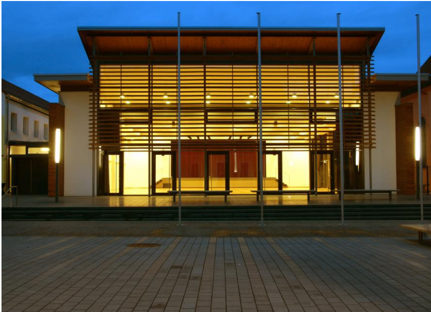
Der neue Luthersaal
