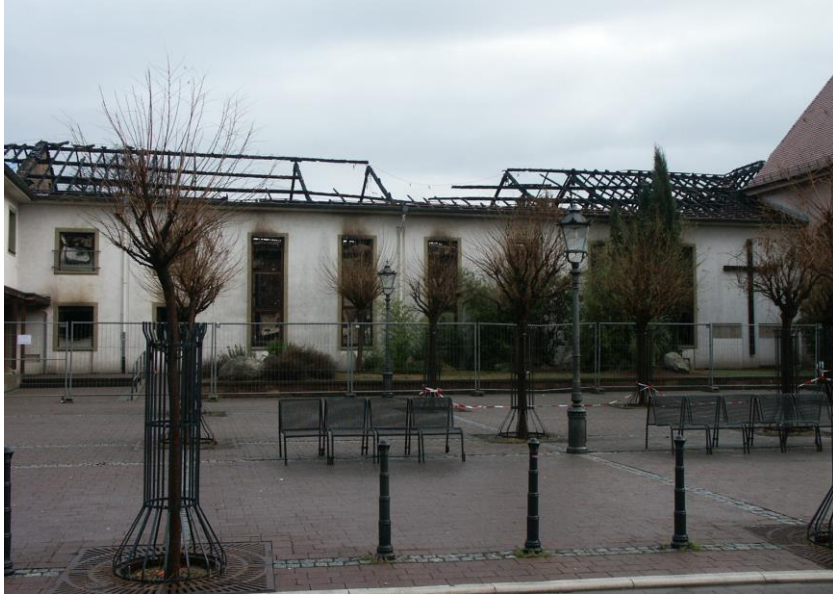
Der abgebrannte alte Luthersaal im Januar 2004
